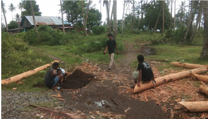
Gambar 4.9 Dokumentasi Pembuatan Gapura
