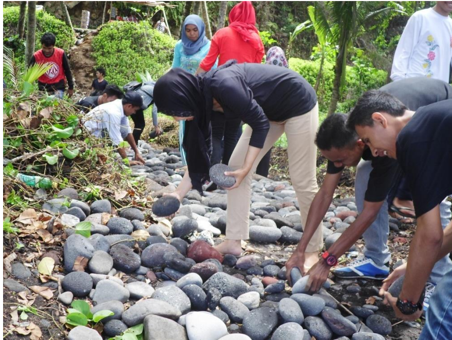
Gambar 18. Pembuatan Jalan Menuju Ke Pantai
